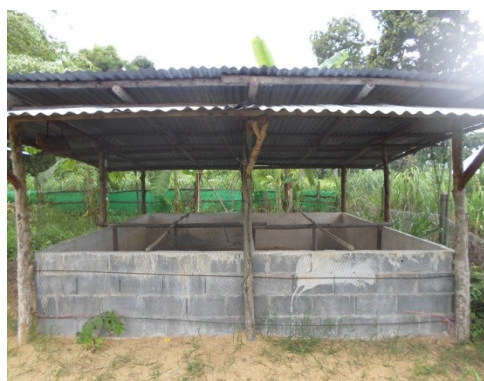
คอกอนุบาล 4*4 เมตร การแบ่งกันด้วยผนังปูนและตาข่ายลวดรวมแบ่งเป็น 4 ห้อง
