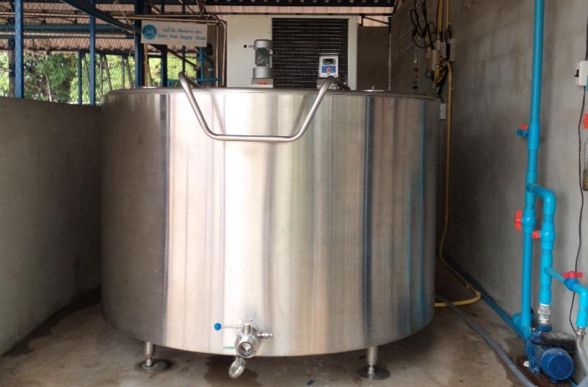
ติดตั้งระบบ Pipe Line และ Cooling Tank (ขนาด 1.5 ตัน) ในฟาร์มโคนม
